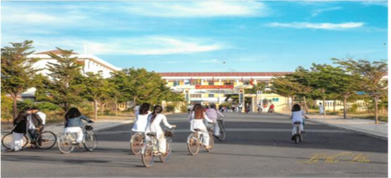
Trường THPT Bùi Thị Xuân được xây dựng vào năm 2005
